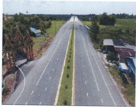
เสาไฟฟ้า
